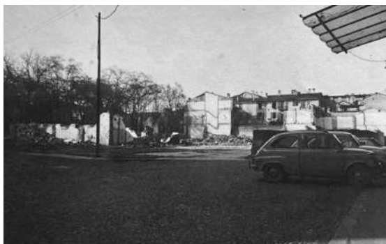
Fig. 7-8 - Area del demolito palazzo Picenardi prima della costruzione dell'edificio posto tra piazza Roma e piazza Filodrammatici (da Il Filo... , 1801-2001)
