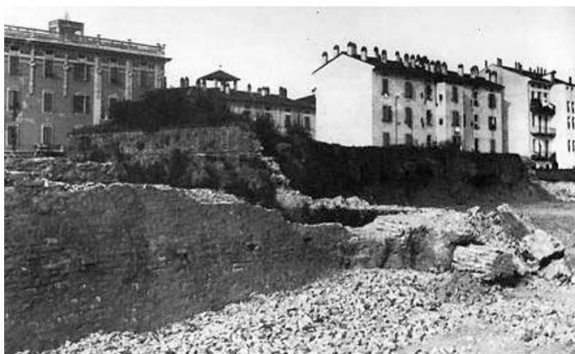
Fig. 8 - Lavori di sterro del bastione del Vecchio Passeggio, inizi secolo XX (Archivio di Stato di Cremona)
