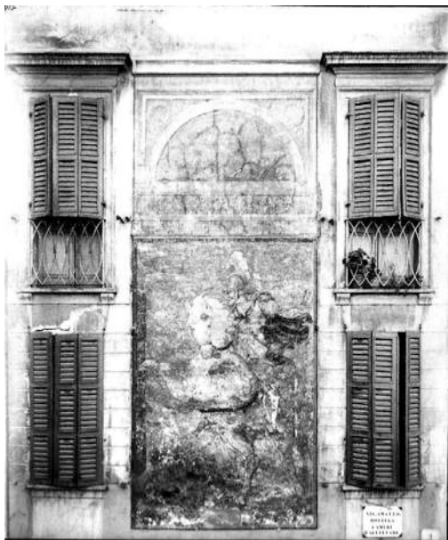
Fig. 4 - Via Curzia (oggi via Gramsci), edificio ora demolito con affresco del sacrificio di Marco Curzio, foto di Pirro Betri, 1903 (Archivio di Stato di Cremona)
