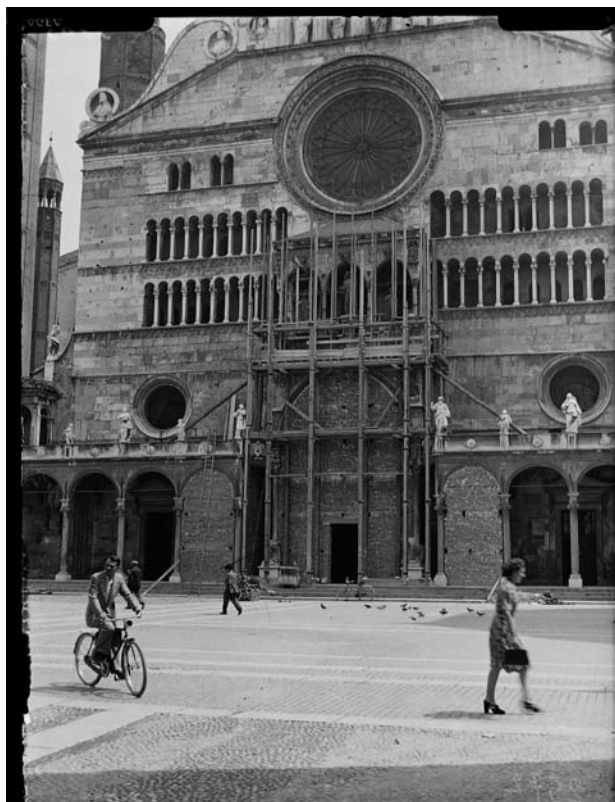
Fig. 18 - Cremona, Facciata della Cattedrale , tamponata, 1940-1945 circa
