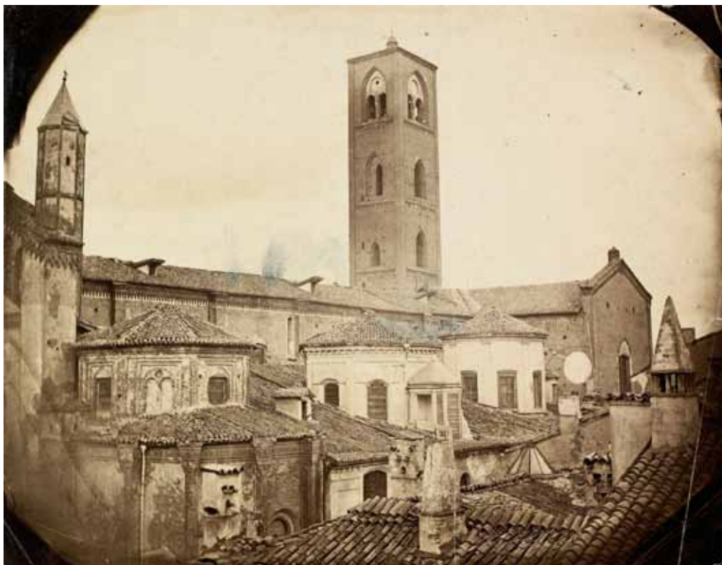
Aurelio Betri, Chiesa di san Domenico, Lato sud con cappelle e il campanile prima della demolizione, [1869] (Archivio di Stato di Cremona)
